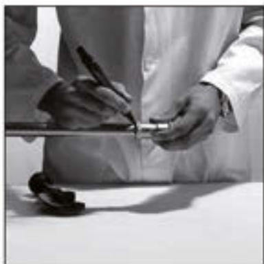
Fig. 20 Inbrengen van de buis in de fitting en de markering
